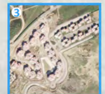
3 Nous habitatges plurifamiliars Nouveaux logements collectifs
