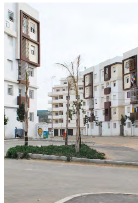
Habitatges plurifamiliars d'obra nova Nouveaux logements collectifs
